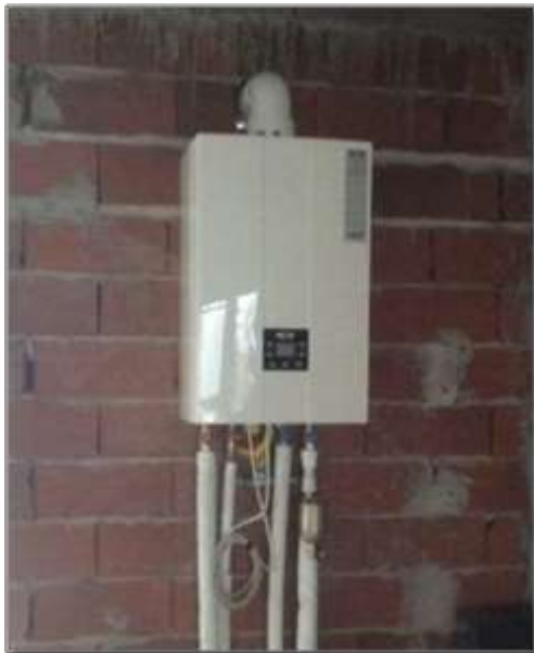
Παραδείγματα εσφαλμένης τοποθέτησης λεβήτων
