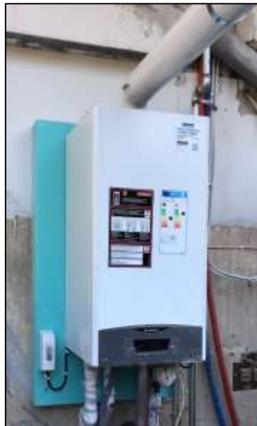
Παραδείγματα εσφαλμένης τοποθέτησης λεβήτων
