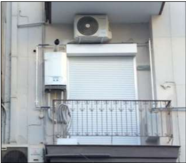
Τοποθέτηση λεβήτων σε μπαλκόνια
